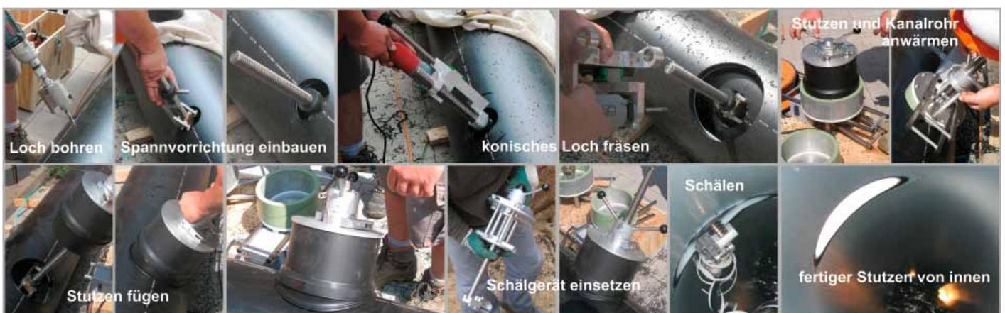
Schweißablauf (Stutzen DA225 SDR 17,6 in Kanal DA 450 SDR 17,6)
